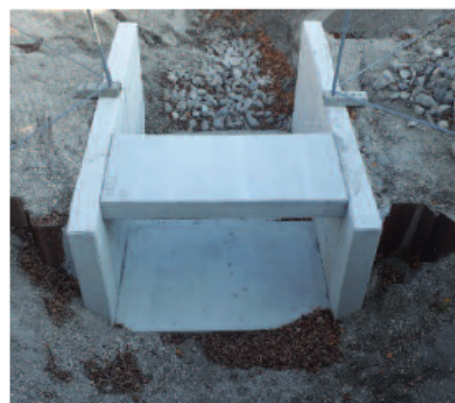
Betonbauwerk für die Wehrklappe
